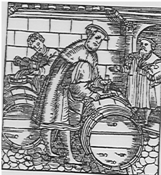
“Cubicadores” ejecutando el Aforo Diagonal
